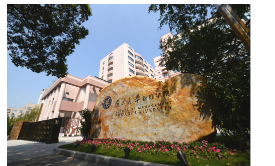
复旦管院国顺院区
